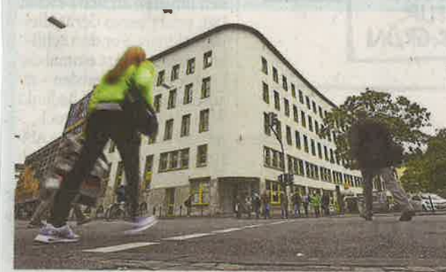
Das Postgebäude am Kolk soll zum Hotel werden. Foto: Andreas Fischer
